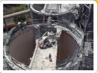
d) Las máquinas, equipos o herramientas que se utilicen en la demolición deben cumplir con mantenimiento preventivo al día y garantizar su estabilidad y seguridad.
