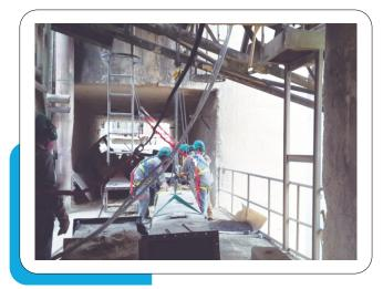
Las aberturas, en paredes o pisos donde se colocan bajantes para escombros, deben estar protegidos con barandillas y rodapiés, además de disponer de protección con apantallamiento de la superficie existente alrededor de las mismas en cada piso.
