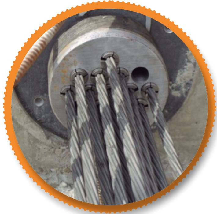
Antes de iniciar con el tensado de los cables, las roscas de postensión deben ser revisadas de previo a su posicionamiento.
