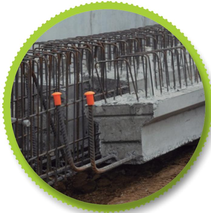
Los grupos de varillas de acero que sean colocados con grúas o equipo especial, deben estibarse de forma que estas no se deslicen.
